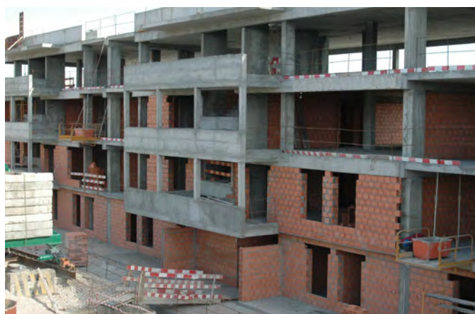
EXECUÇÃO DE ALVENARIA DE TIJOLOS
