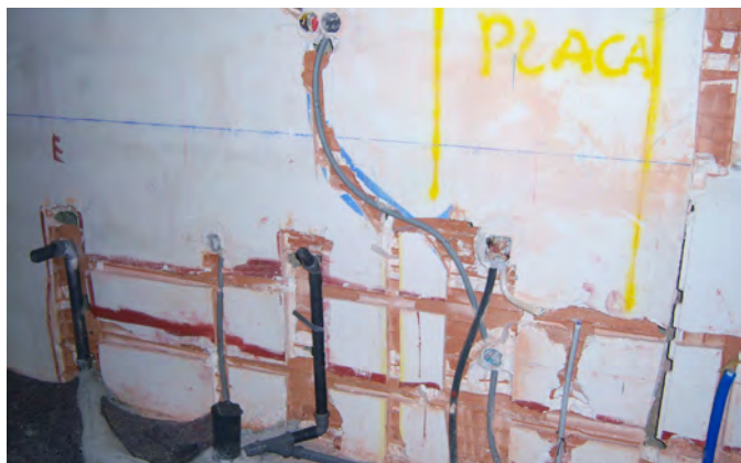
ABERTURA DE ROÇOS NAS PAREDES
