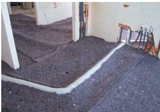
TUBAGEM PARA ENFIAMENTO ELÉCTRICO SOB O PAVIMENTO
