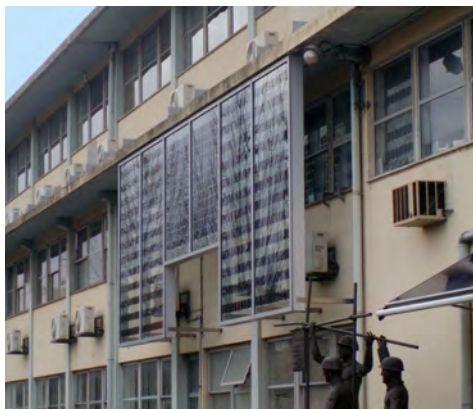
FORNECIMENTO DE ENERGIA ELÉCTRICA ATRAVÉS DE PAINÉIS FOTOVOLTAICOS
