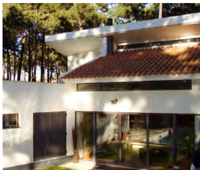
COBERTURA EM TELHADO
