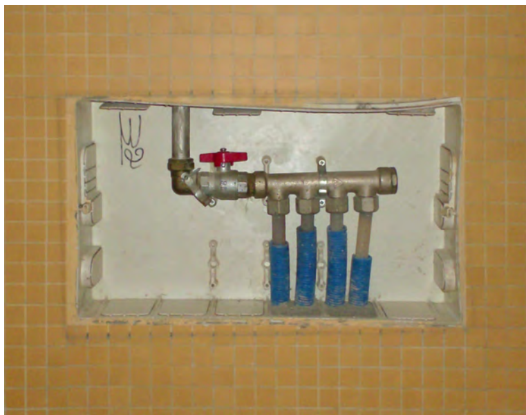
CAIXA DE TERMINAIS PEX
