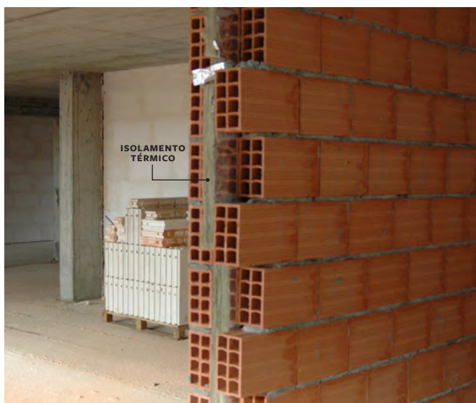
PAREDE DUPLA COM CAIXA DE AR
