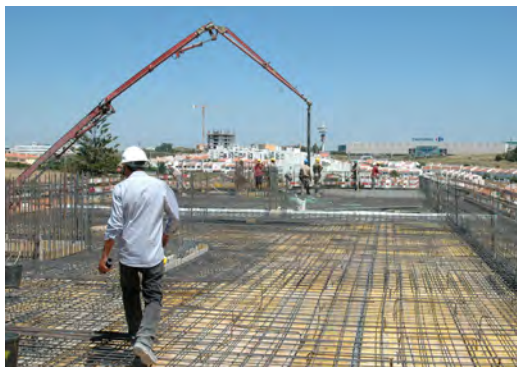
ENCHIMENTO OU BETONAGEM DE UMA LAGE
