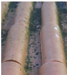
TELHAS FISSURADAS
