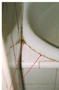
SILICONE DETERIORADO
