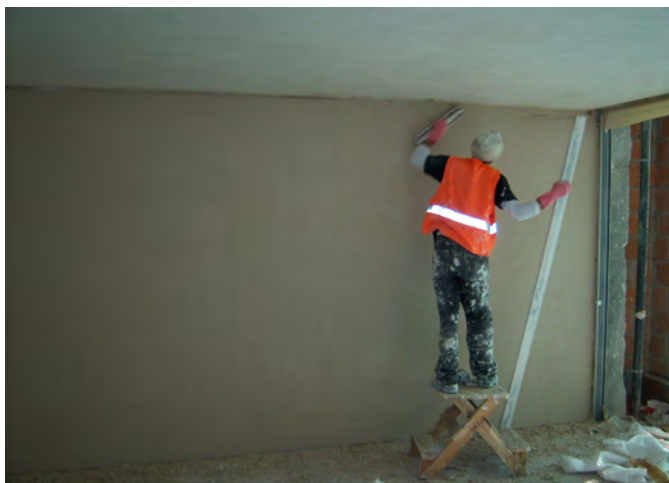
APLICAÇÃO DE ESTUQUE EM PAREDE
